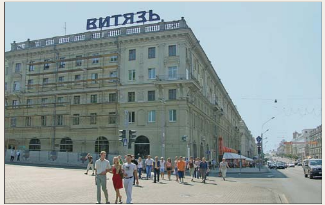
Сооруженный на месте гостиницы «Париж» в 1950-х гг. жилой дом (2008 г.).
